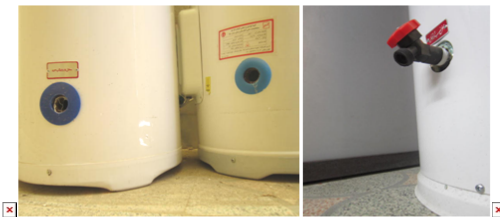
شکل شش : چند نمونه از محل قرار گیری دریوش تخلیه در آبگرمکن ها
