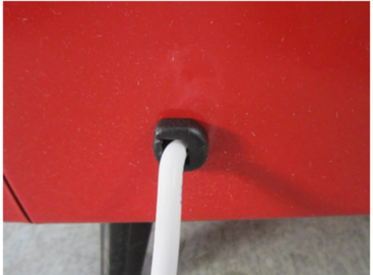
۱. کابلگیر های مسیری
